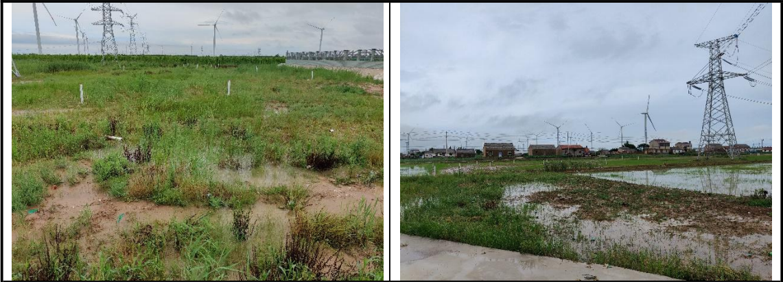
图 4.1-17 电缆敷设段及施工临时占地植被恢复
