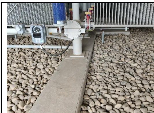
图 4.1-26 主要电气设备安装减震垫
