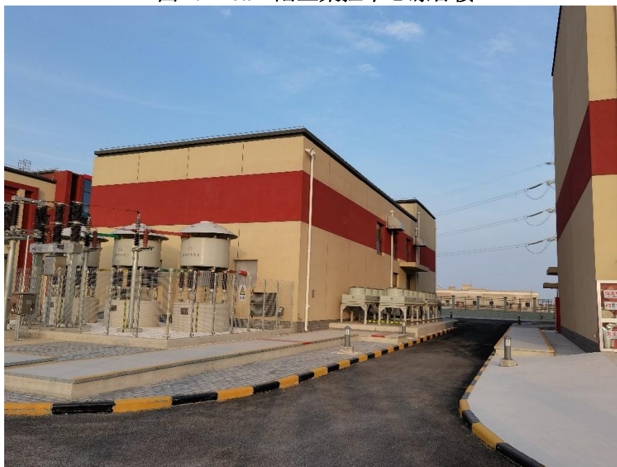
图 2.2-10b 陆上集控中心 SVG 楼
