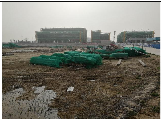
图 4.1-15 建筑材料采取苫盖措施
