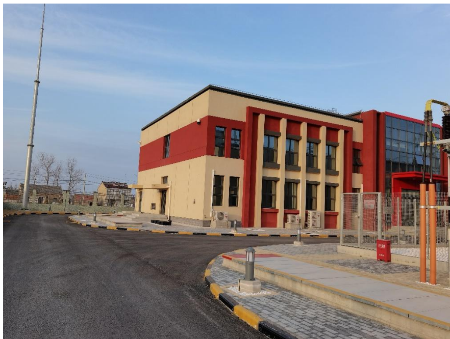
图 2.2-10a 陆上集控中心综合楼
