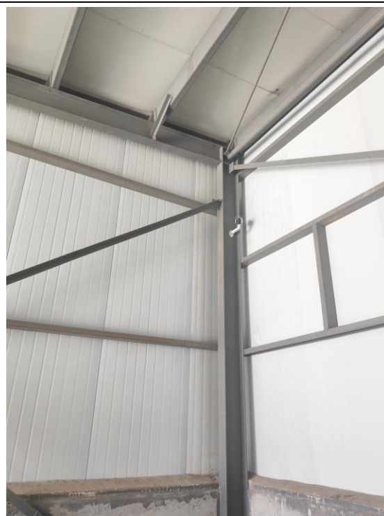
库内视频监控
