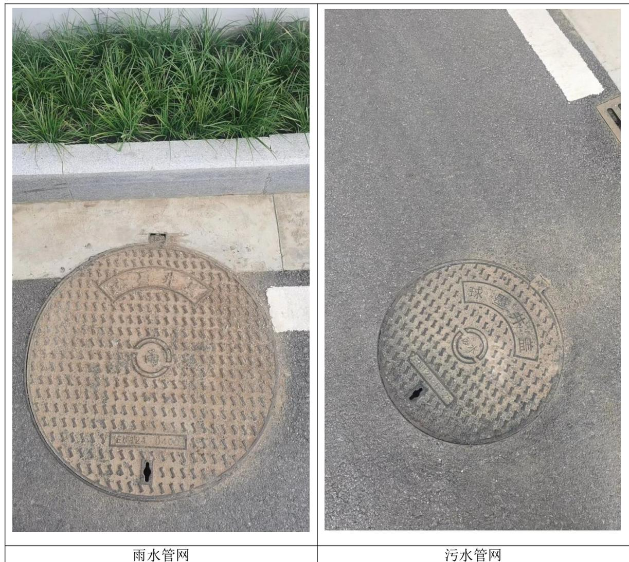
图 3-1 项目雨污管网图
