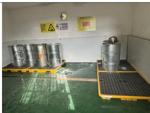
危废库内部防渗漏托盘
