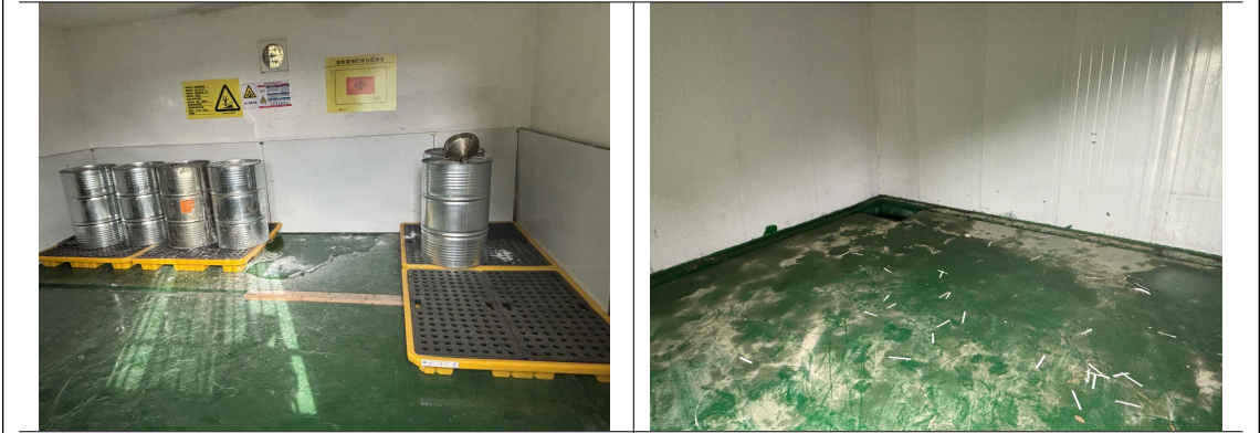
危废库内部防渗漏托盘
