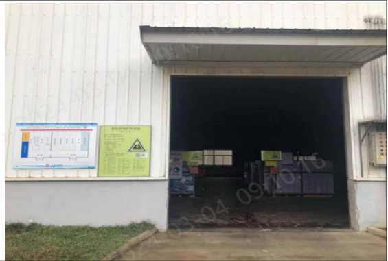
危险废物贮存设施（第 4-2 号）
