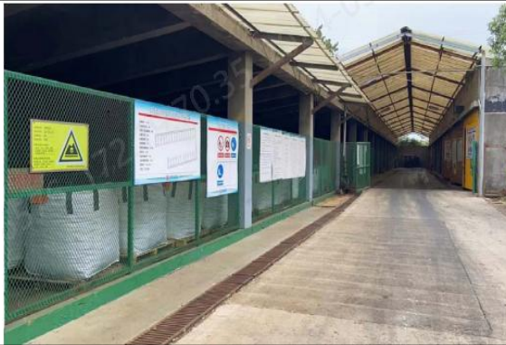
危险废物贮存设施（第 4-1 号）
