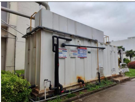
厂区污水处理站（调节池+隔油池+絮凝沉淀池+水解酸化池+AO）
