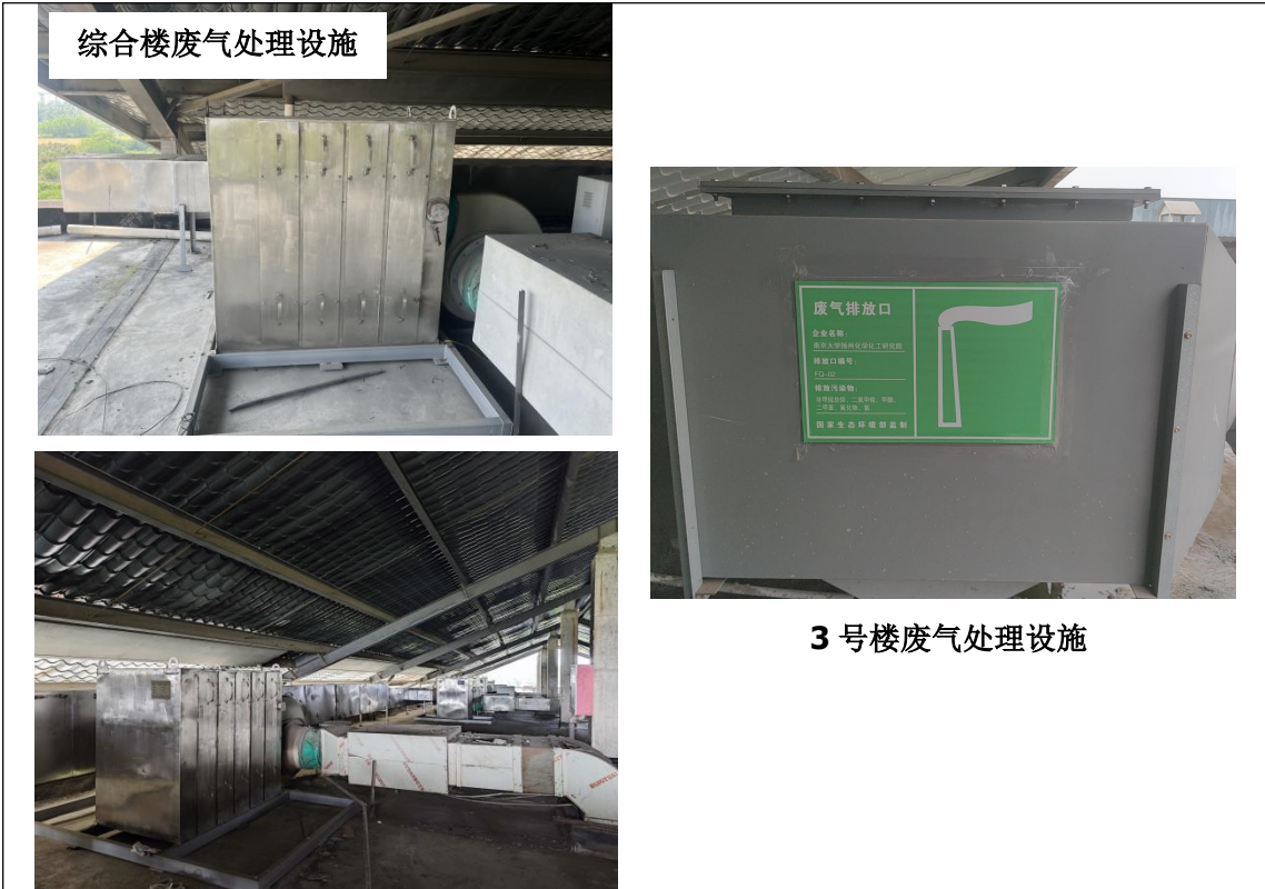
图 3-2 本项目废气处理装置图
