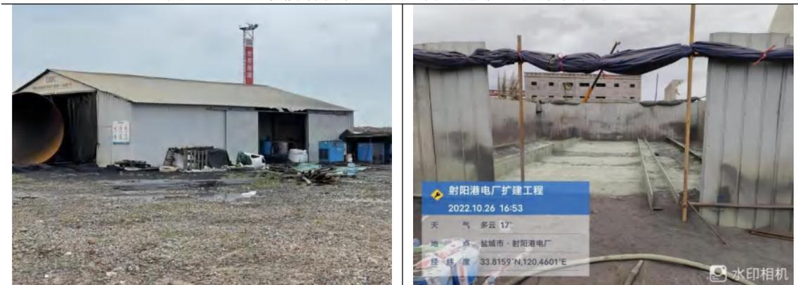
图 5.1-12 焊接喷漆等预制施工采取封闭措施
