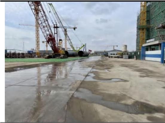
图 5.1-2 施工道路硬化
