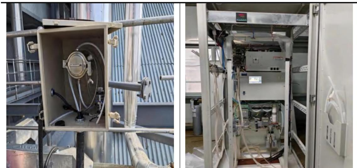
图 5.2-50 脱硝进口 CEMS 安装情况
