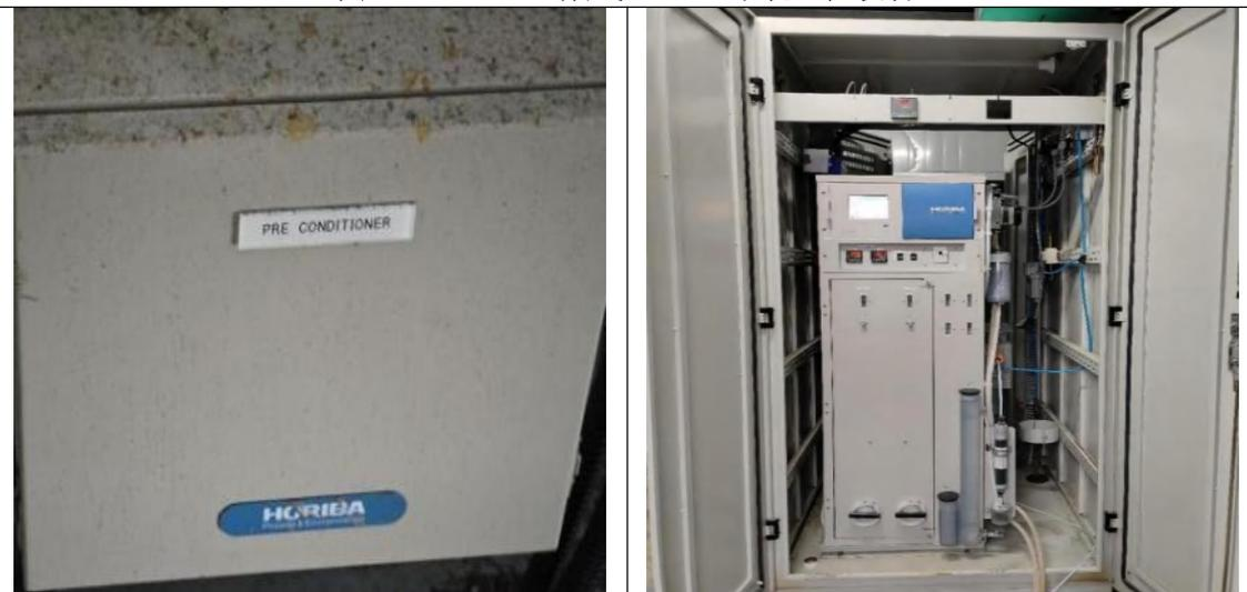
图 5.2-49 脱硝出口 CEMS 安装情况
