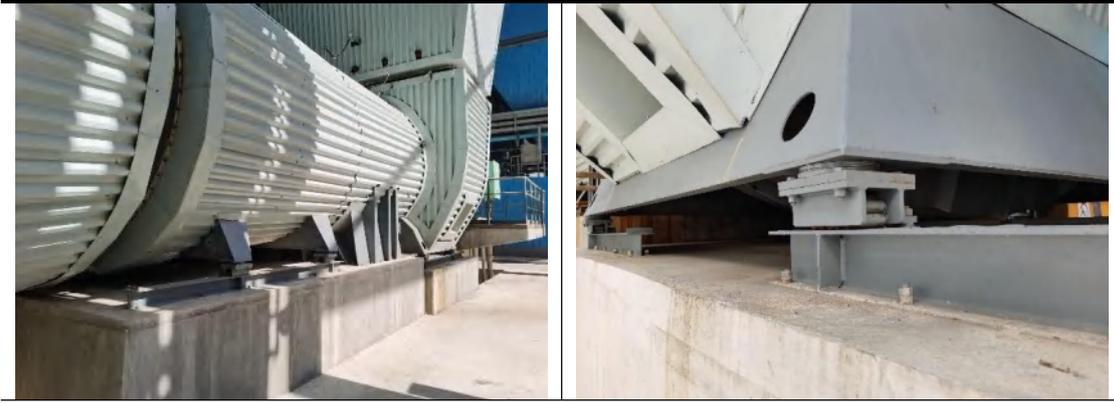
图 5.2-21 风机减振基础
