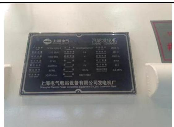
图 3.3-4 #1 机组汽轮发电机铭牌
