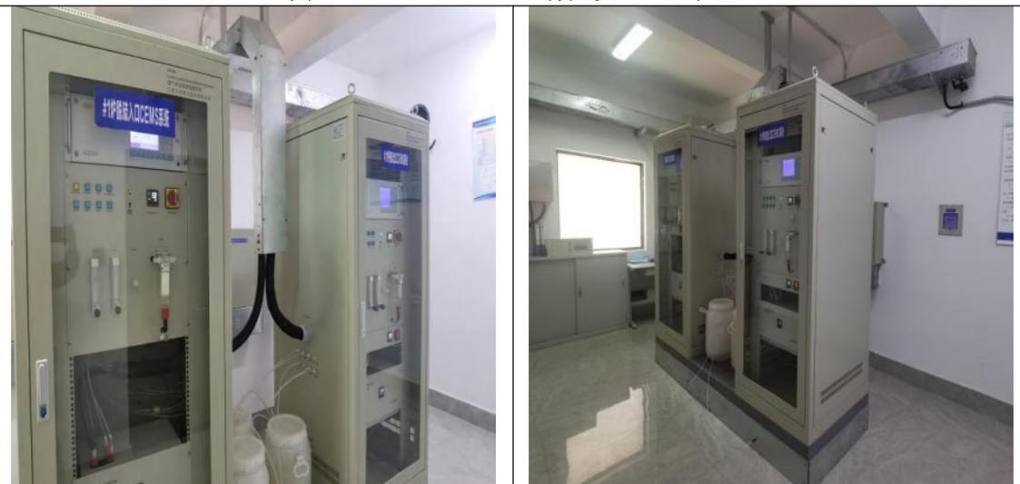
图 5.2-48 FGD 烟气 CEMS 系统监控设备
