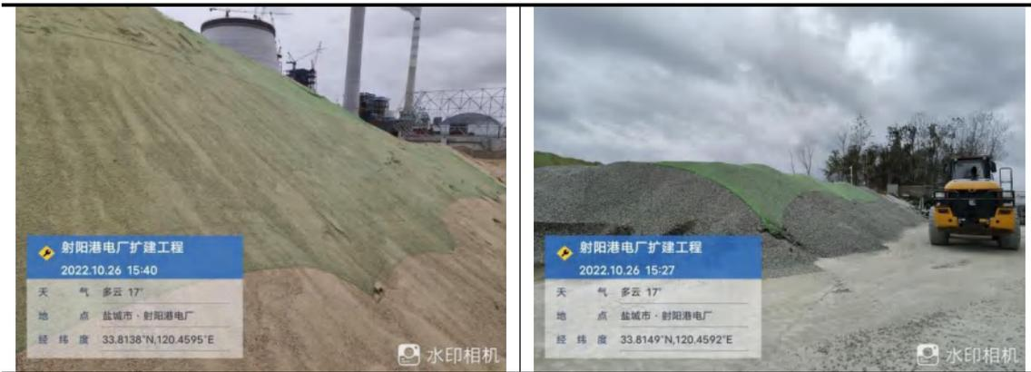
图 5.1-7 施工材料覆盖防尘网
