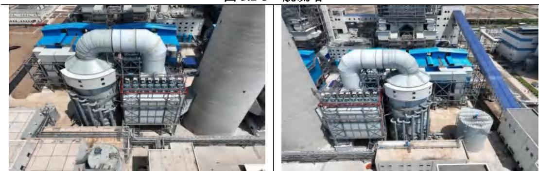
图 5.2-4 脱硫塔及湿式电除尘设备
