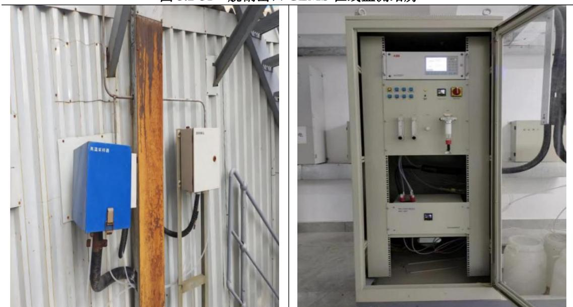
图 5.2-52 脱硫进口 CEMS 安装情况
