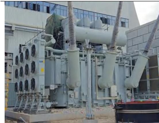
图 3.3-13 主变压器
