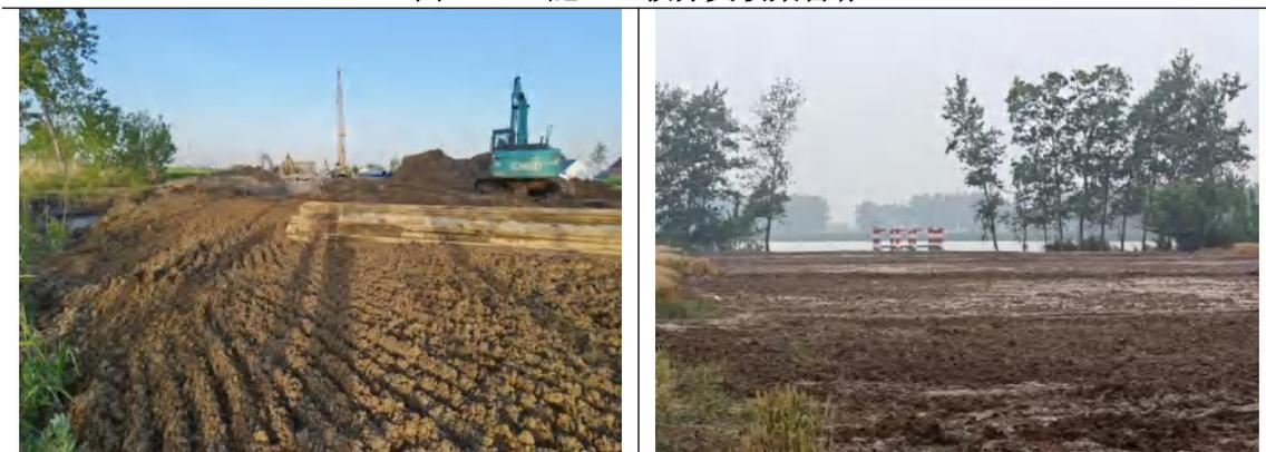
图 5.1-9 地表水取水管线开挖后及时回填
