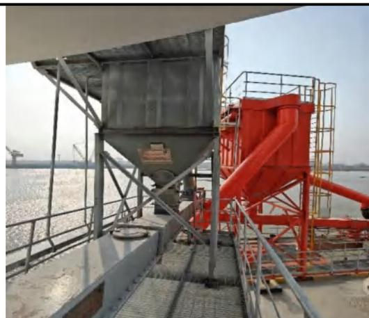
图 5.2-6 船装机输送斜槽收尘器及船装机收尘器
