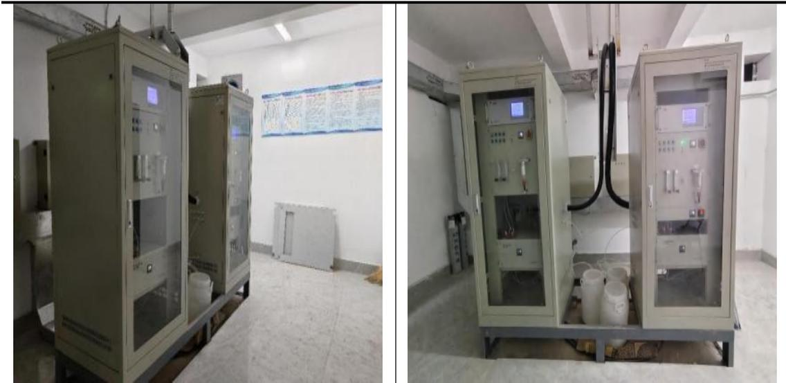
图 5.2-53 脱硫入口 CEMS 在线监测站房
