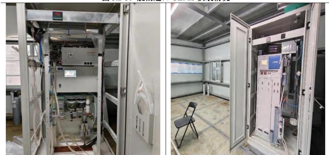
图 5.2-51 脱硝出口 CEMS 在线监测站房
