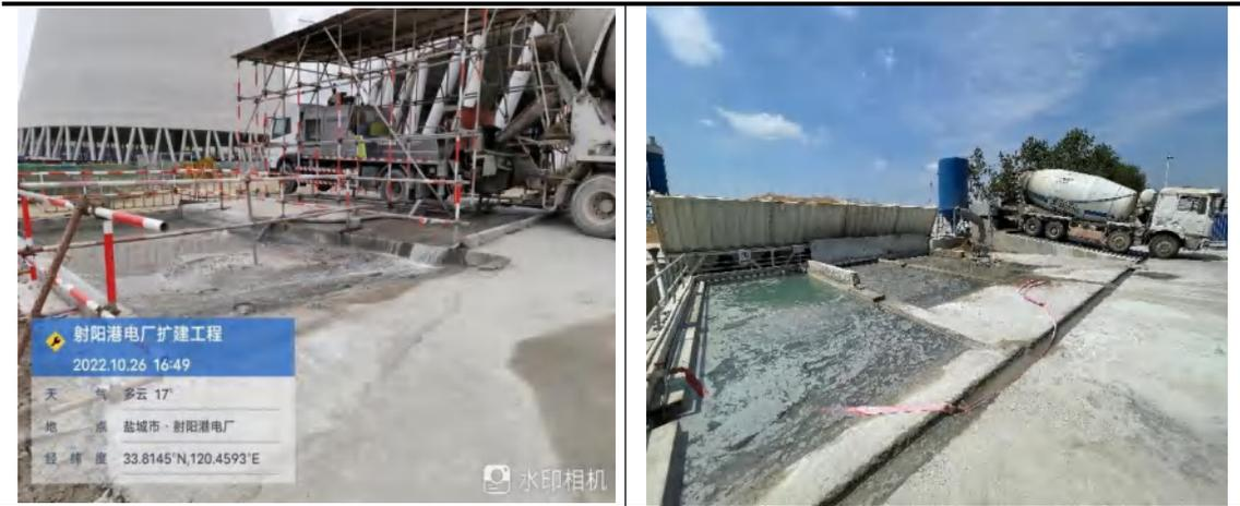
图 5.1-11 车辆清洗设施及配套的排水、泥浆沉淀设施
