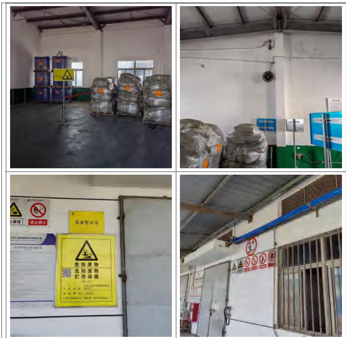
图 3-4 危废库现场及标识标牌照片
