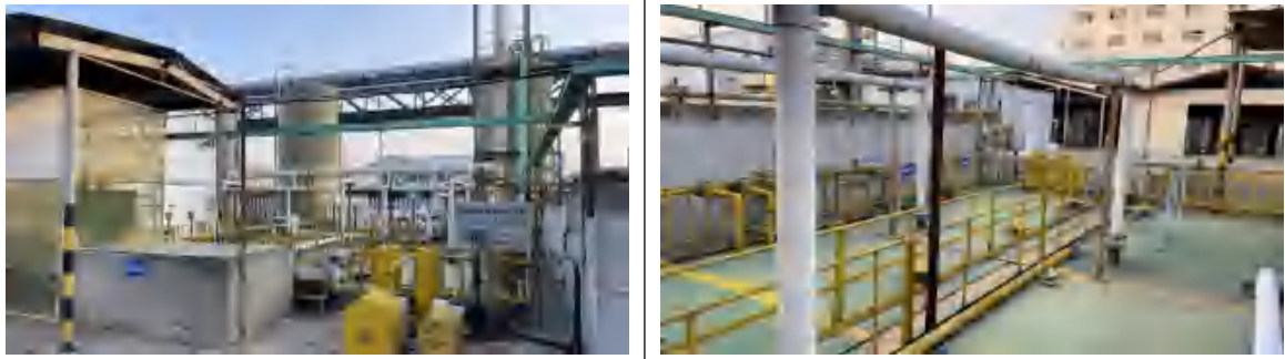
图 3-2 污水站现场照片
