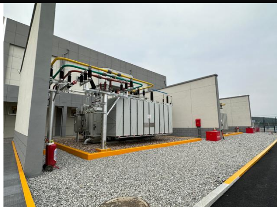
图 6.8 主变周围设置实体围墙
