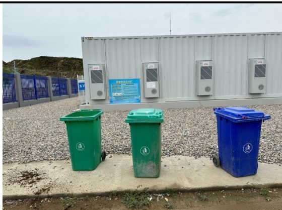
图 6.1 陆上施工现场垃圾分类
