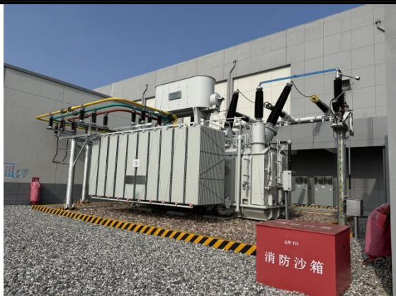
图 6.7 主变接地、降噪
