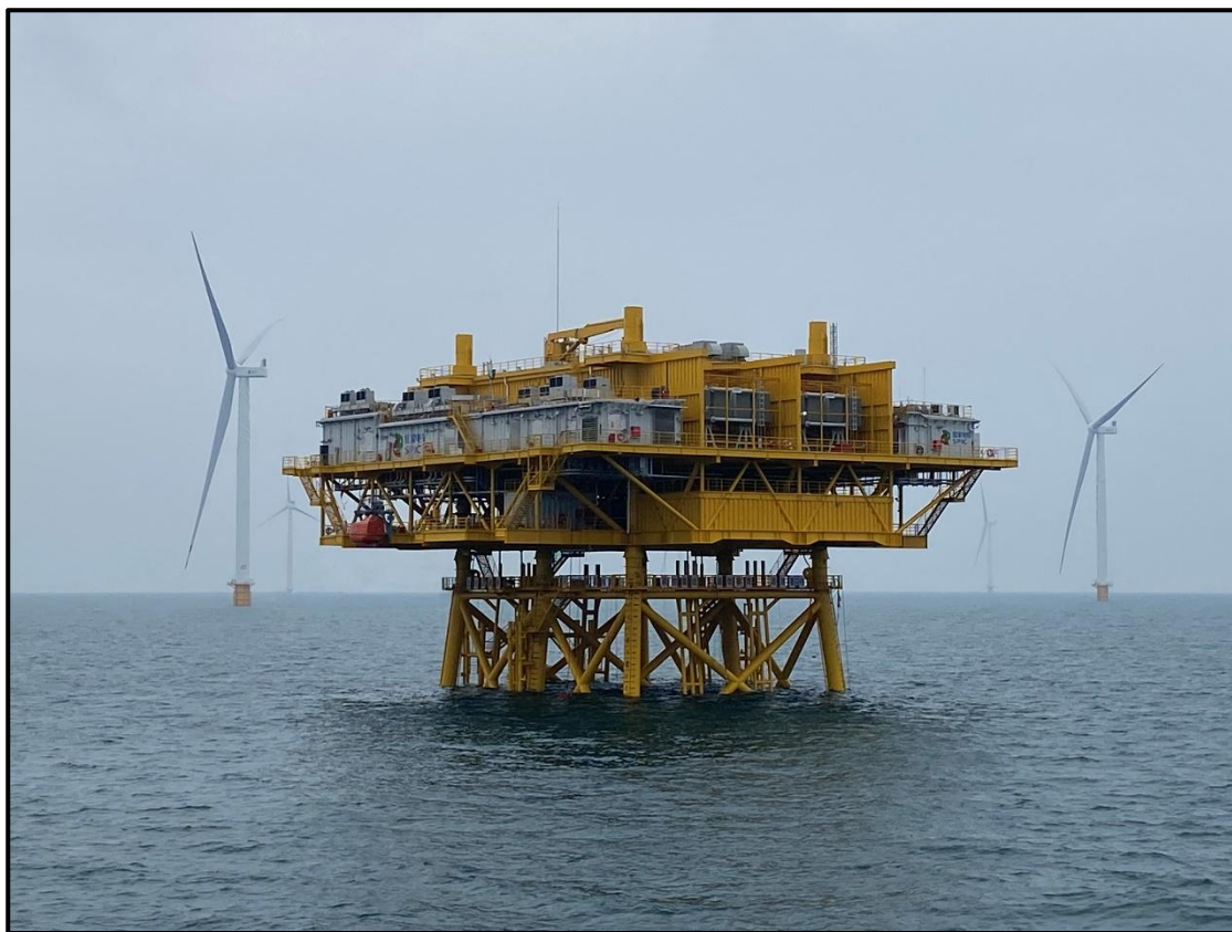
图 2.2-6 海上升压站现状图（依托）
