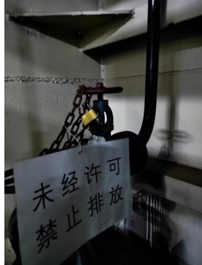
施工船舶油水分离器铅封
