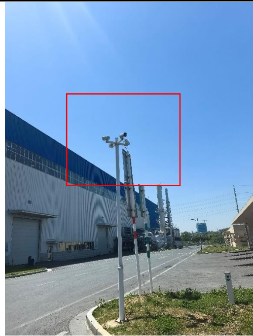
危废暂存间的外部摄像头
