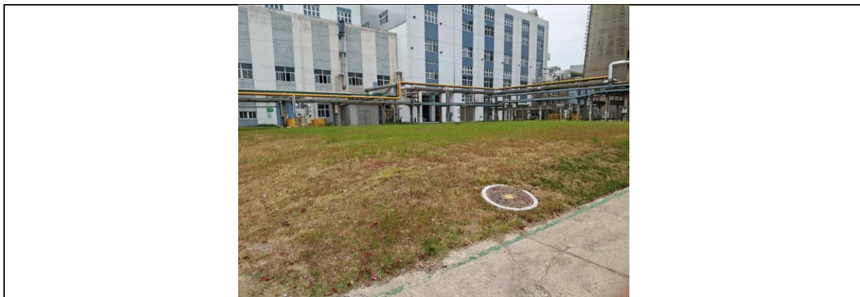
原 3 台 20t/h 燃气（油）锅炉所在地
