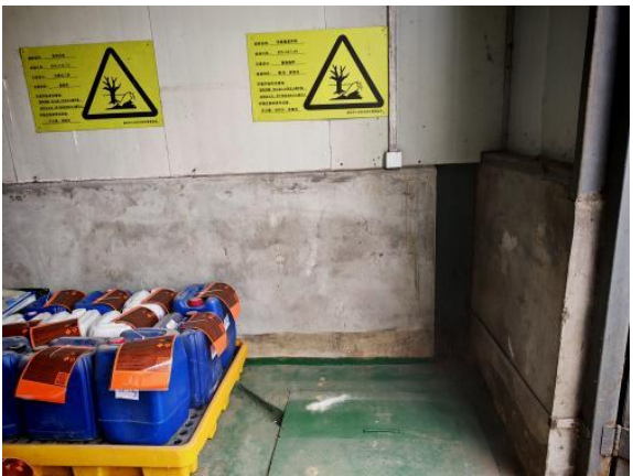
环氧地坪及导流槽
