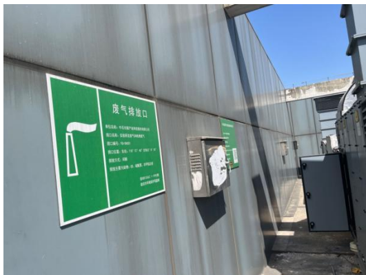
DA001 排气筒废气排放口标识牌
