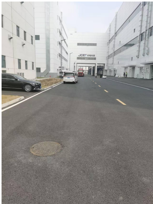
变电站南侧绿化与硬化
