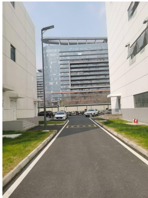
变电站东侧绿化与硬化
