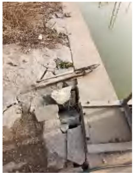
(4) 上游右侧砌石翼墙后砌石破损
