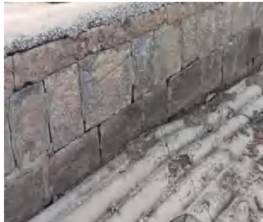
(10) 下游右侧砌石翼墙砂浆勾缝脱落，模袋混凝土护坡断裂
