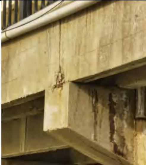
(7) 桥板局部破损，钢筋外露锈蚀
