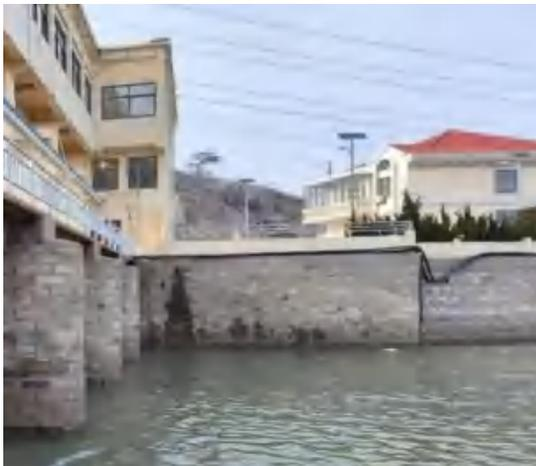
(9) 下游左侧砌石翼墙开裂渗水
