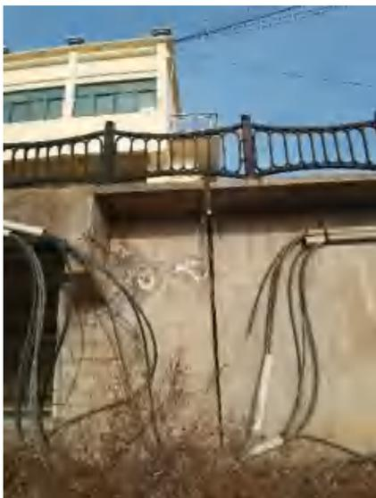
(5) 右侧空箱岸墙伸缩缝开裂
