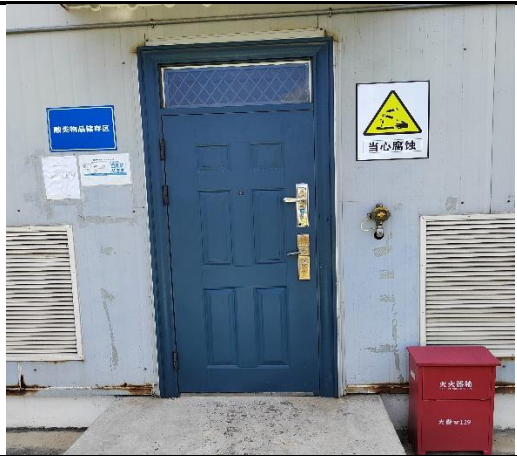
现有危化品仓库的酸类物品储存区（外部）
